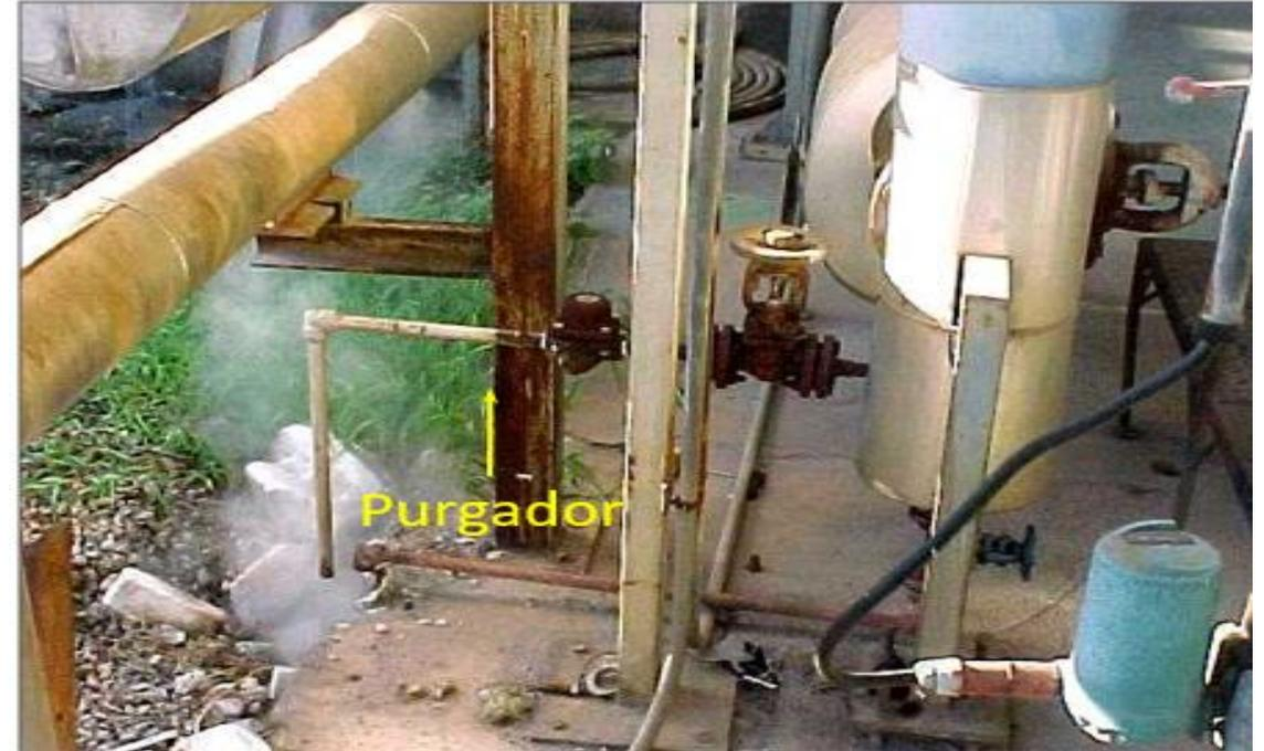
Drenagem do condensado com reevaporação
